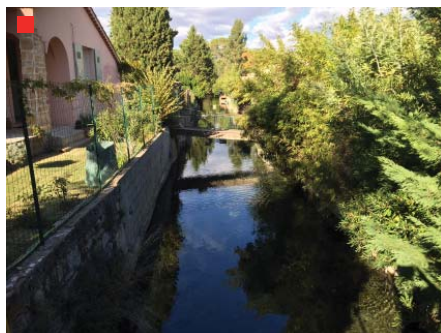
Les reprises de murets doivent se faire selon le même motif de maçonnerie (et non en parpaings, béton banché ou autre motif brut...).
