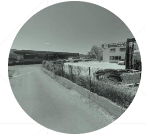
Entrées de ville dégradées
